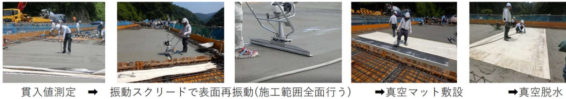
写真 6 表面再振動工法作業の流れ
